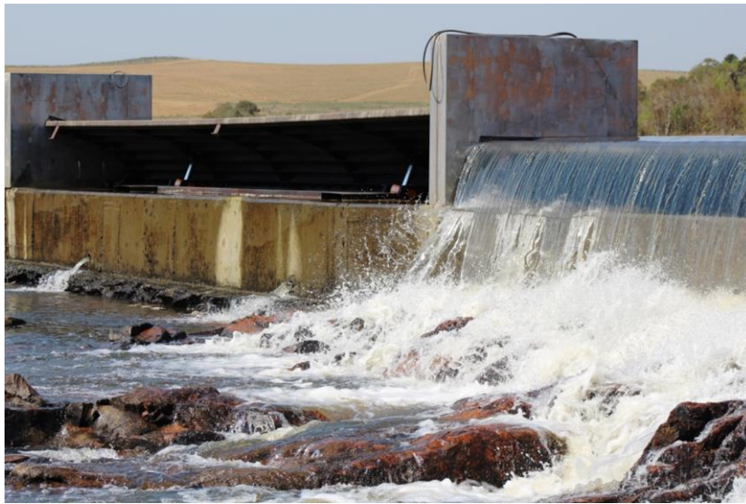
4. Operação das comportas basculantes permite regular a vazão
