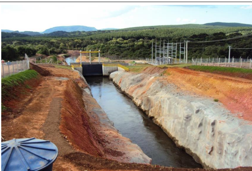
15. Final do canal adutor depois do túnel
