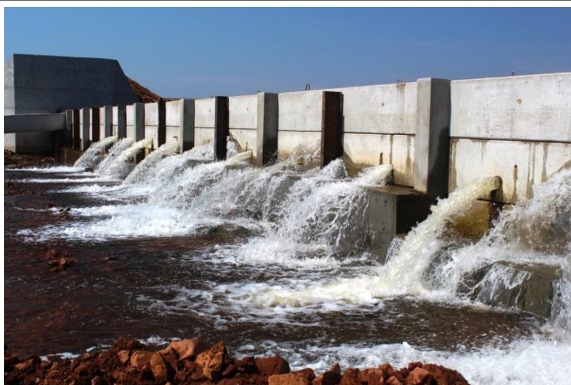
7. .Adufas da vazão ecológica garantem fluxo permanente a jusante
