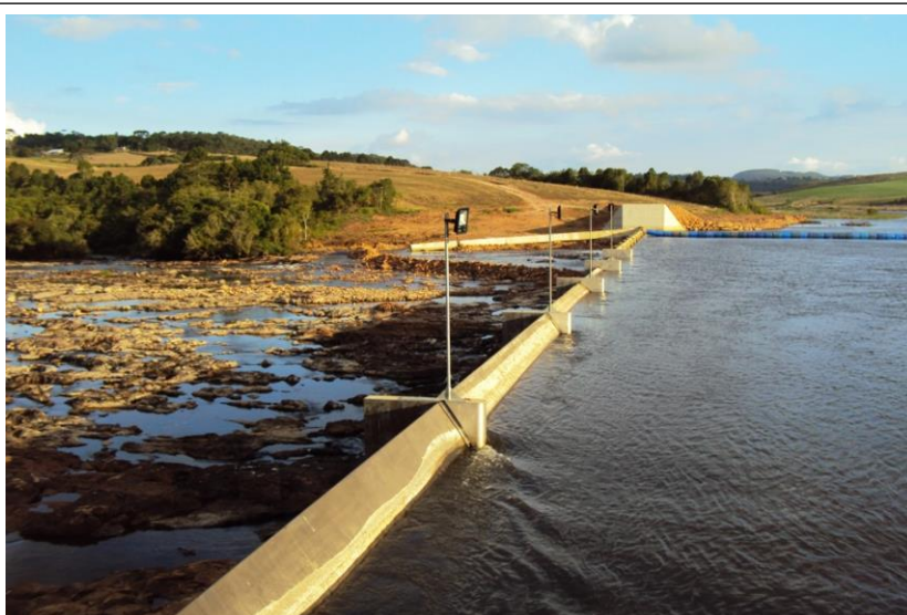
3. Barragem da PCH CASTRO vertendo pelas adufas da vazão ecológica
