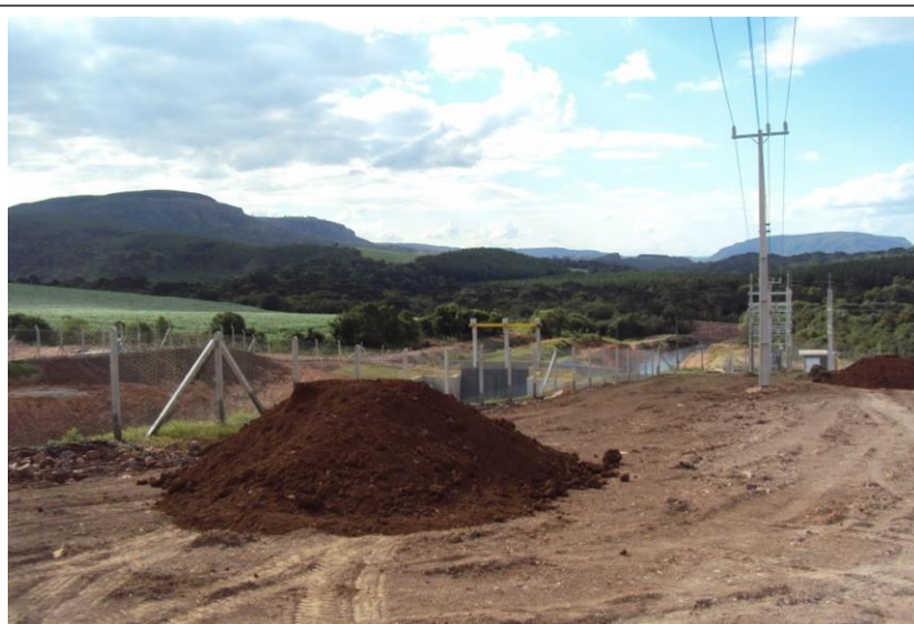
20. Áreas do canteiro recebem recobrimento de solos férteis e grama
