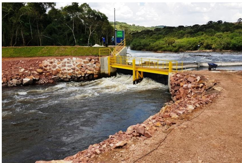
11. Grade visa a reduzir a entrada de macrófitas ao sistema gerador
