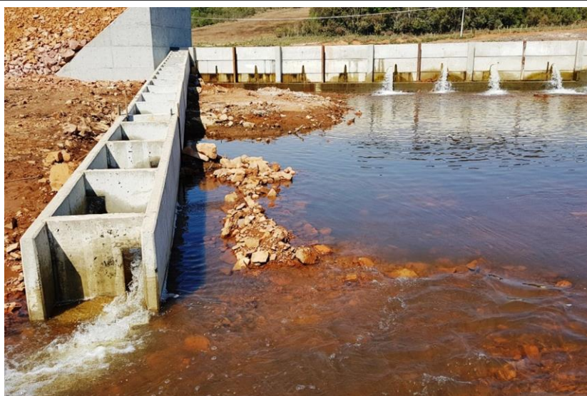
9. Escada experimental será ajustada para melhorar a migração
