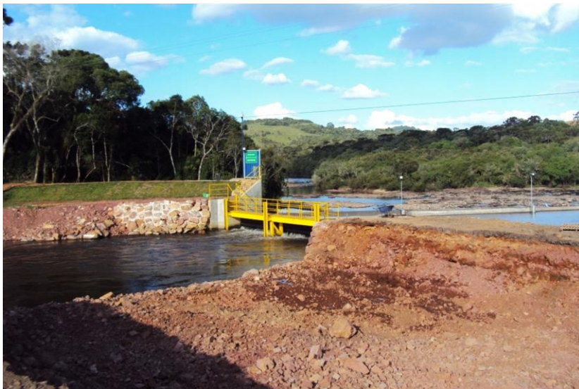
10. Sistema de adução desvia as águas do rio para a Casa de Força
