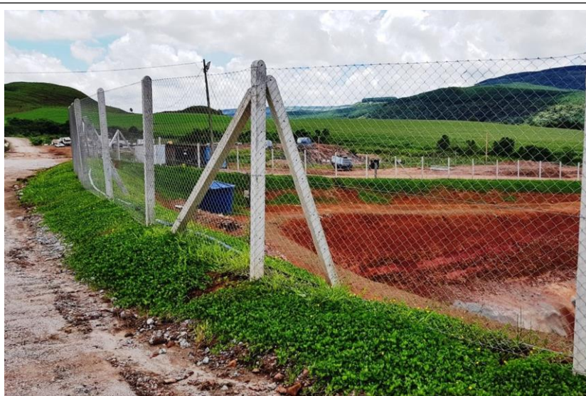
18. Barreira gramada protege canal adutor e evita erosão do solo
