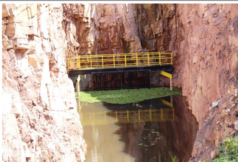
14. Emboque do túnel: macrófitas retidas pelas grades
