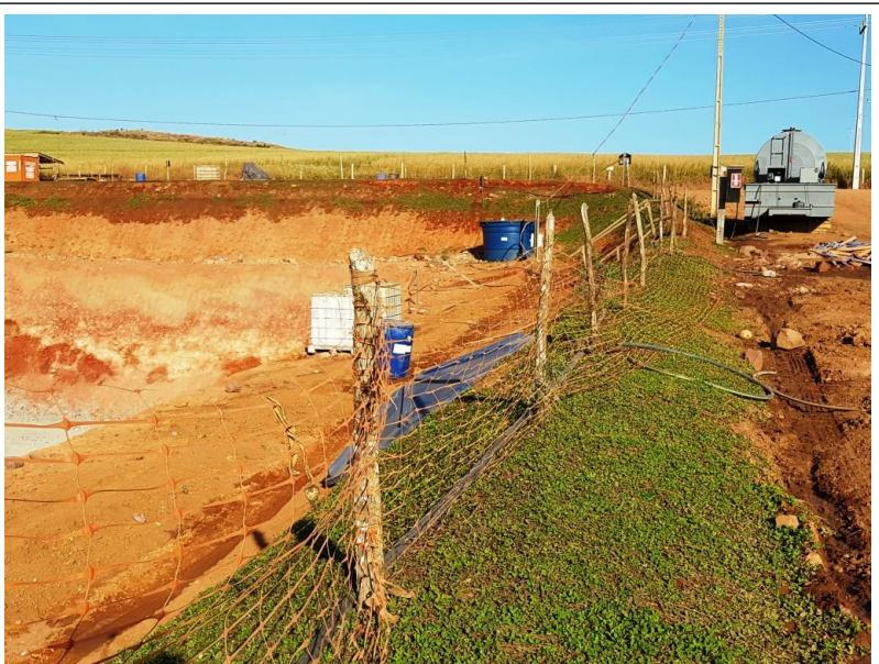
Figura 04: Taludes com gramados, para conter águas pluviais e evitar erosão
