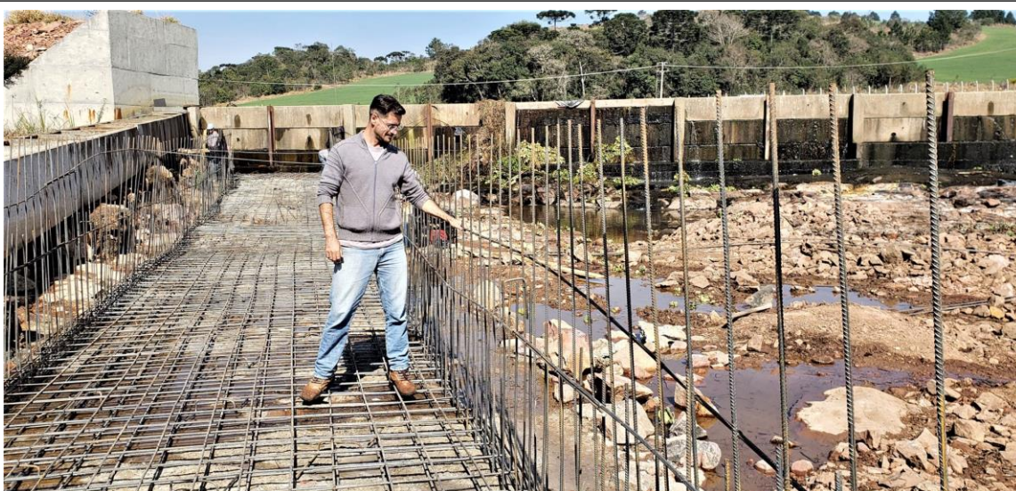
8. Engenheiro examina construção da nova escada de peixes da PCH CASTRO
