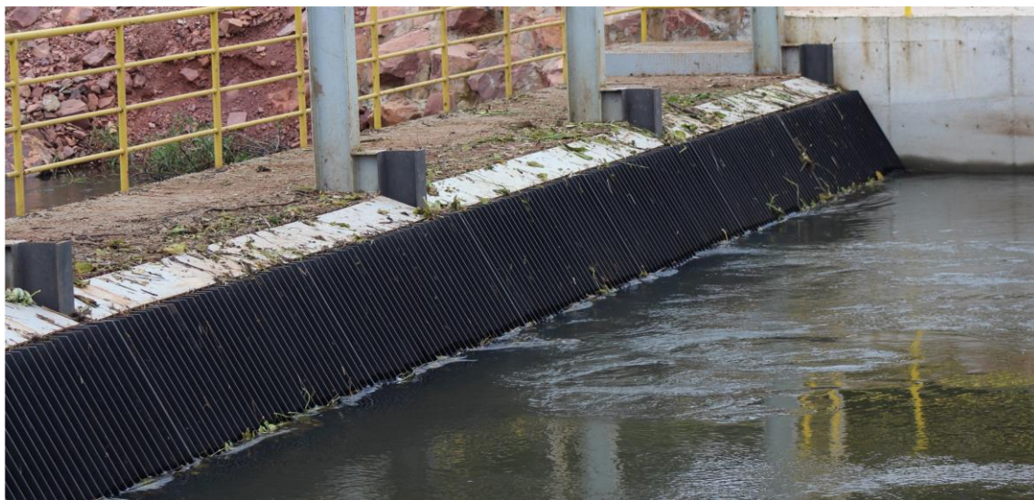
7. .Novas grades no canal de adução: providência para atenuar efeitos das ilhas flutuantes
