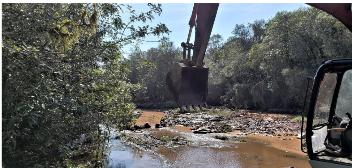
9. Abertura de canal no TVR aumentará volume de água atraindo para a nova escada de peixes
