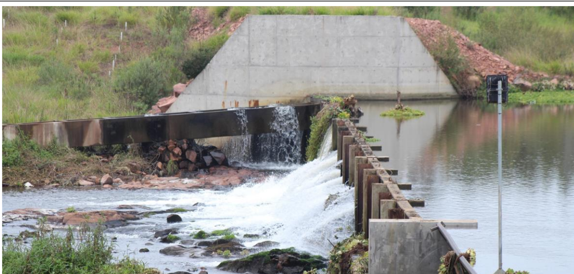
3. Vertendo pelas adufas da vazão ecológica: risco de entupimento pelas macrófitas aquáticas.
