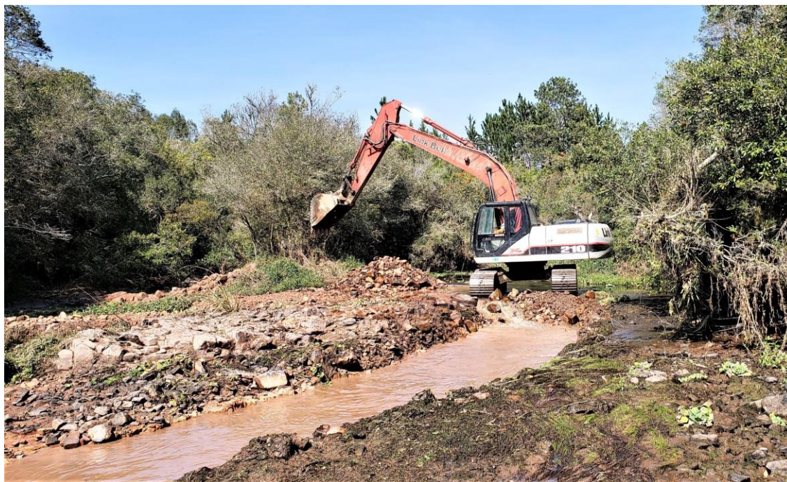
Figura 02: Canal a jusante da escada de peixes da PCH CASTRO facilitará a mobilização dos peixes
