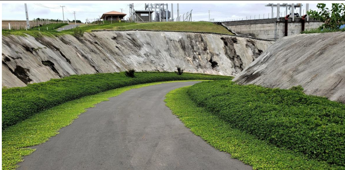
Figura 04 taludes e margens dos acessos protegidos contra riscos de erosão laminar
