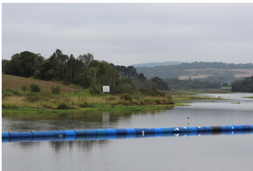
4. Dispositivo (loog-boom) para reter plantas e materiais flutuantes
