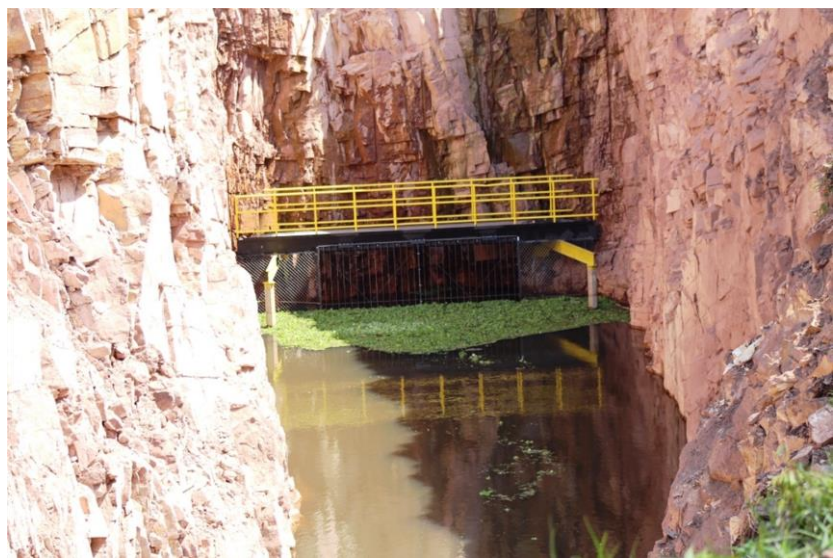
14. Emboque do túnel: macrófitas retidas pelas grades
