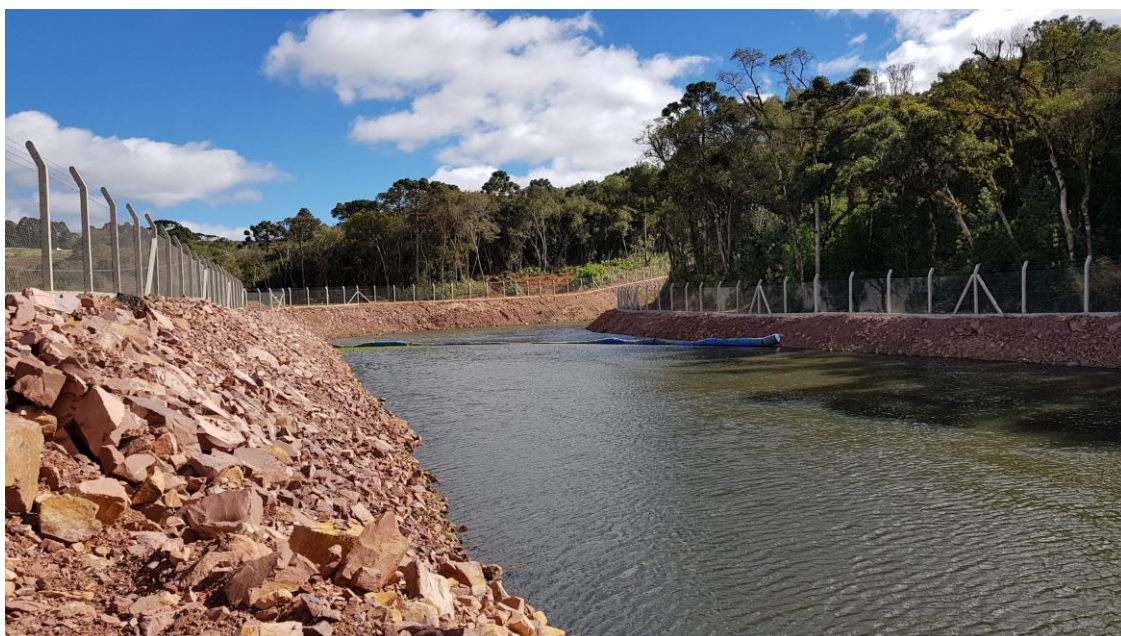
Figura 05: cercas no canal adutor da PCH Castro, com altura adequada à proteção da fauna.
