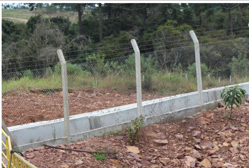
7. .Cercas para fauna, com fundação adequada para evitar passagens .
