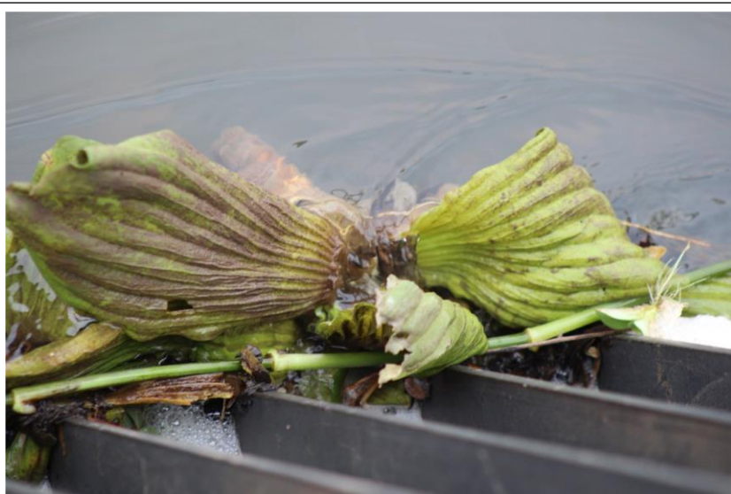
3. Epífitas barradas nas grades da adução da PCH CASTRO
