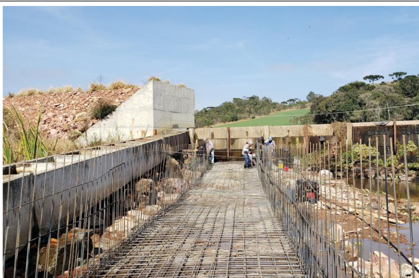
6 Obras da Escada de Peixes por onde também fluirá a vazão ecológica.q
