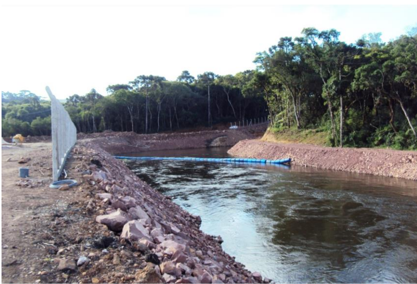
13. Canal adutor com log-boom para reter macrófitas flutuantes
