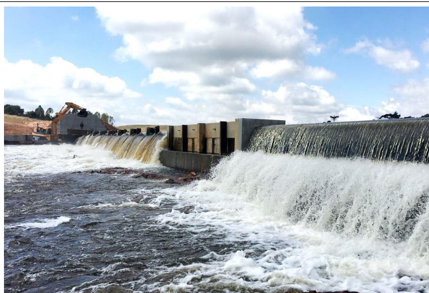
Figura 02: Barramento sem pranchão libera maior volume d'água – e macrófitas
