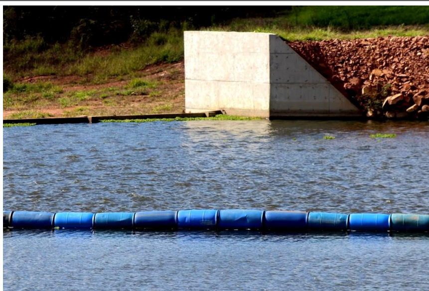
Figura 04: Log-booms cercam as ilhas de macrófitas e as conduzem a jusante.
