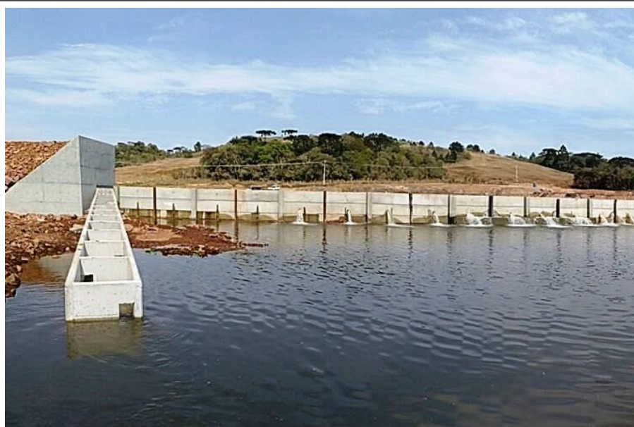
Figura 18. Escada de peixe e dutos de vazão sanitária da PCH Castro.
