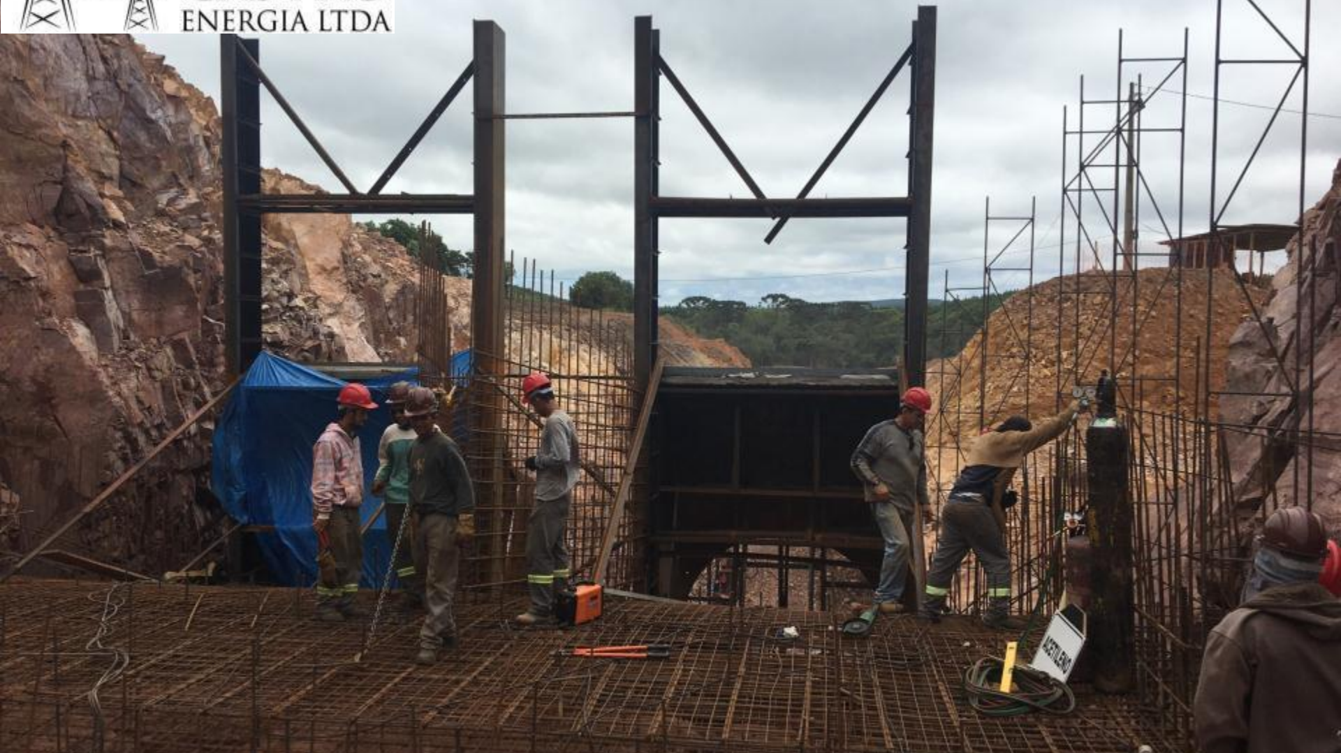
TOMADA D'ÁGUA EXECUÇÃO DAS ARMADURAS DA LAJE DE FUNDO E GABARITOS DAS PAREDES
