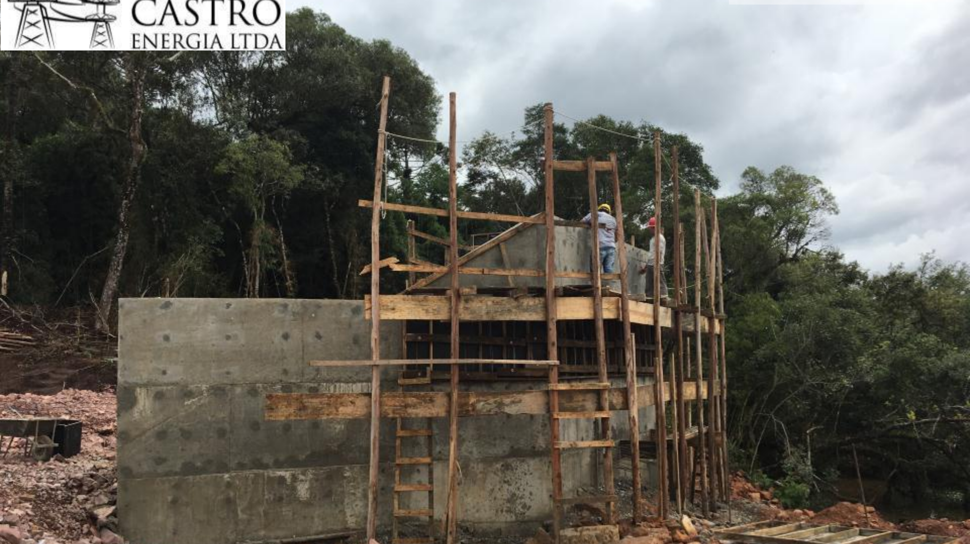
BARRAGEM VERTEDOURO MURO ESQUERDO DO VERTEDOURO – CONCRETAGENS CONCLUÍDAS- EXECUÇÃO DE DESFORMA E ACABAMENTOS
