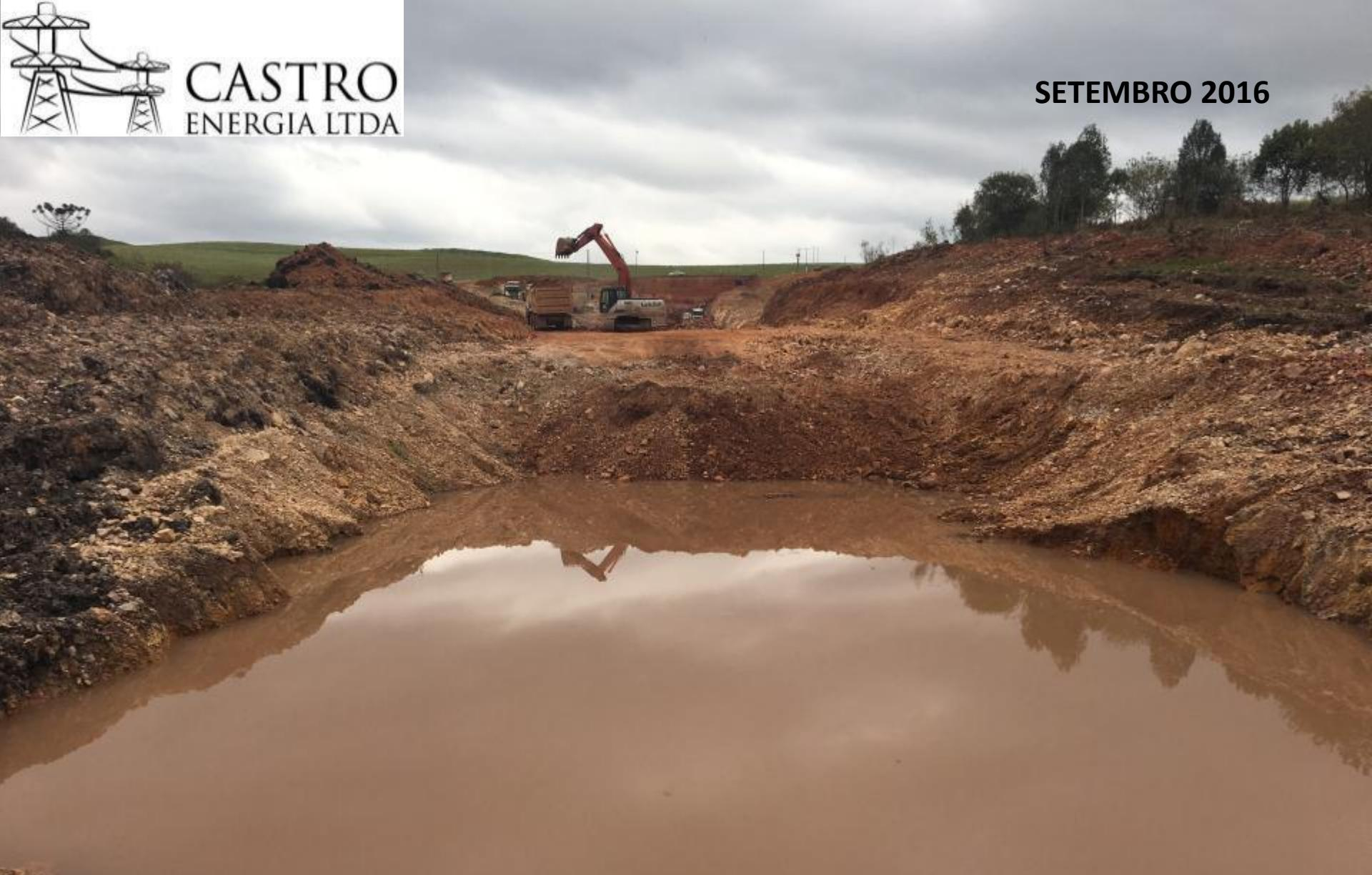
**ESCAVAÇÃO DO MATERIAL DETONADO NO CANAL DE FUGA
