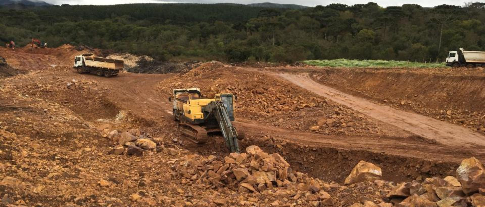
REMOÇÃO DE ROCHA DESMONTADA A FOGO NA REGIÃO DA CASA DE
