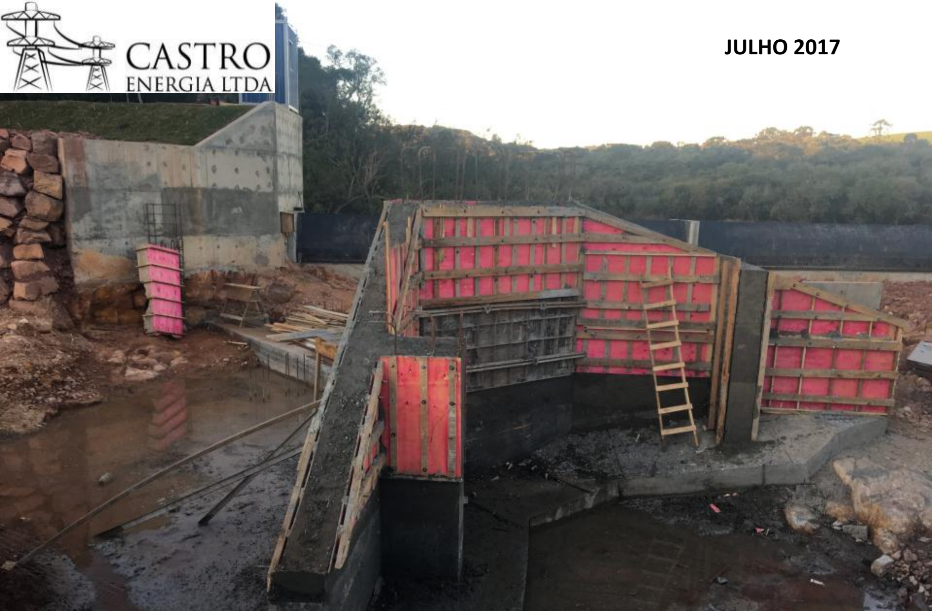
MURO DA TOMADA DE ÁGUA DO CANAL DESFORMA
