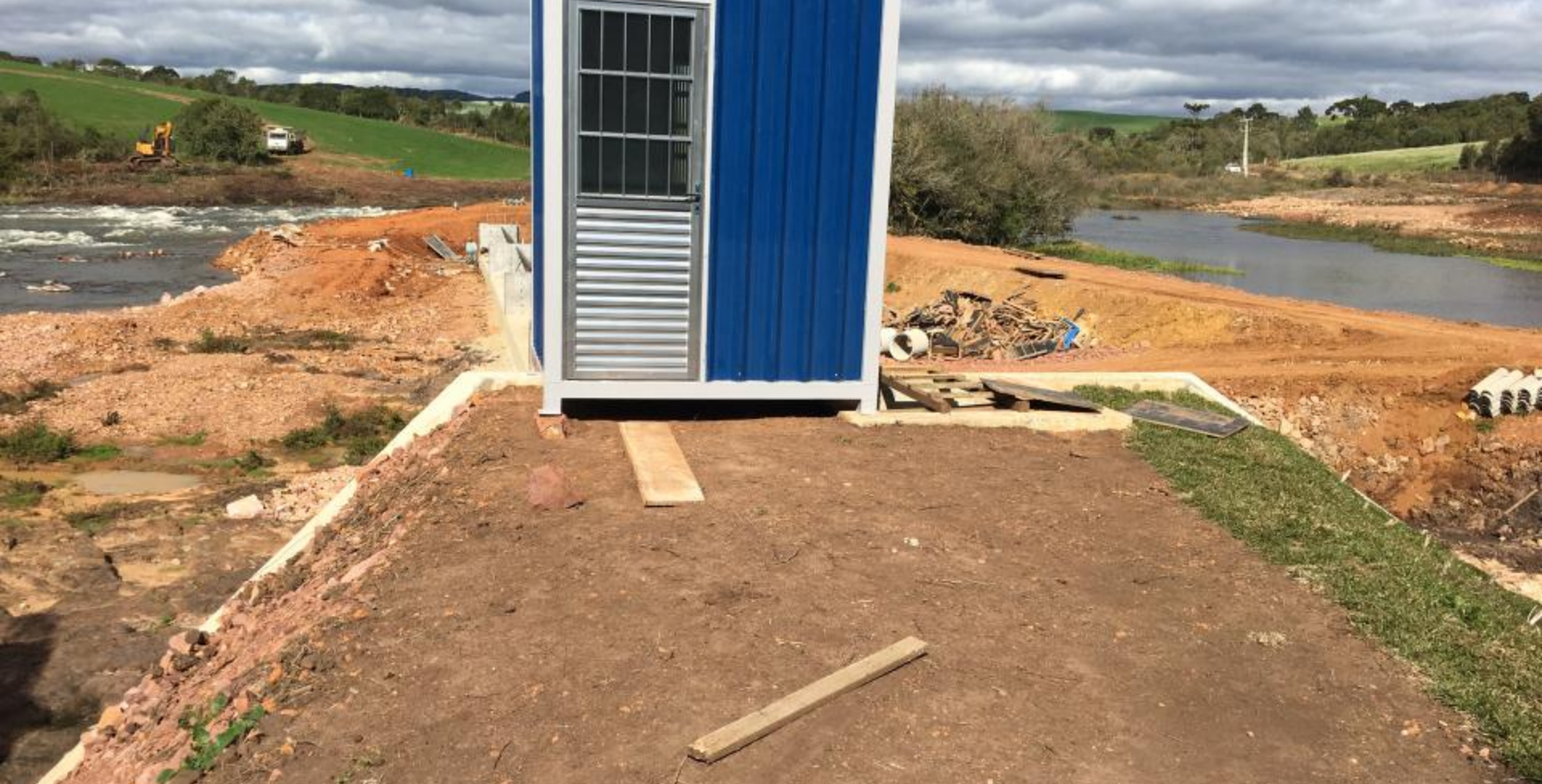
BARRAGEM VERTEDOURO ABRIGO DA UNIDADE HIDRÁULICA DE ACIONAMENTO DAS COMPORTAS
