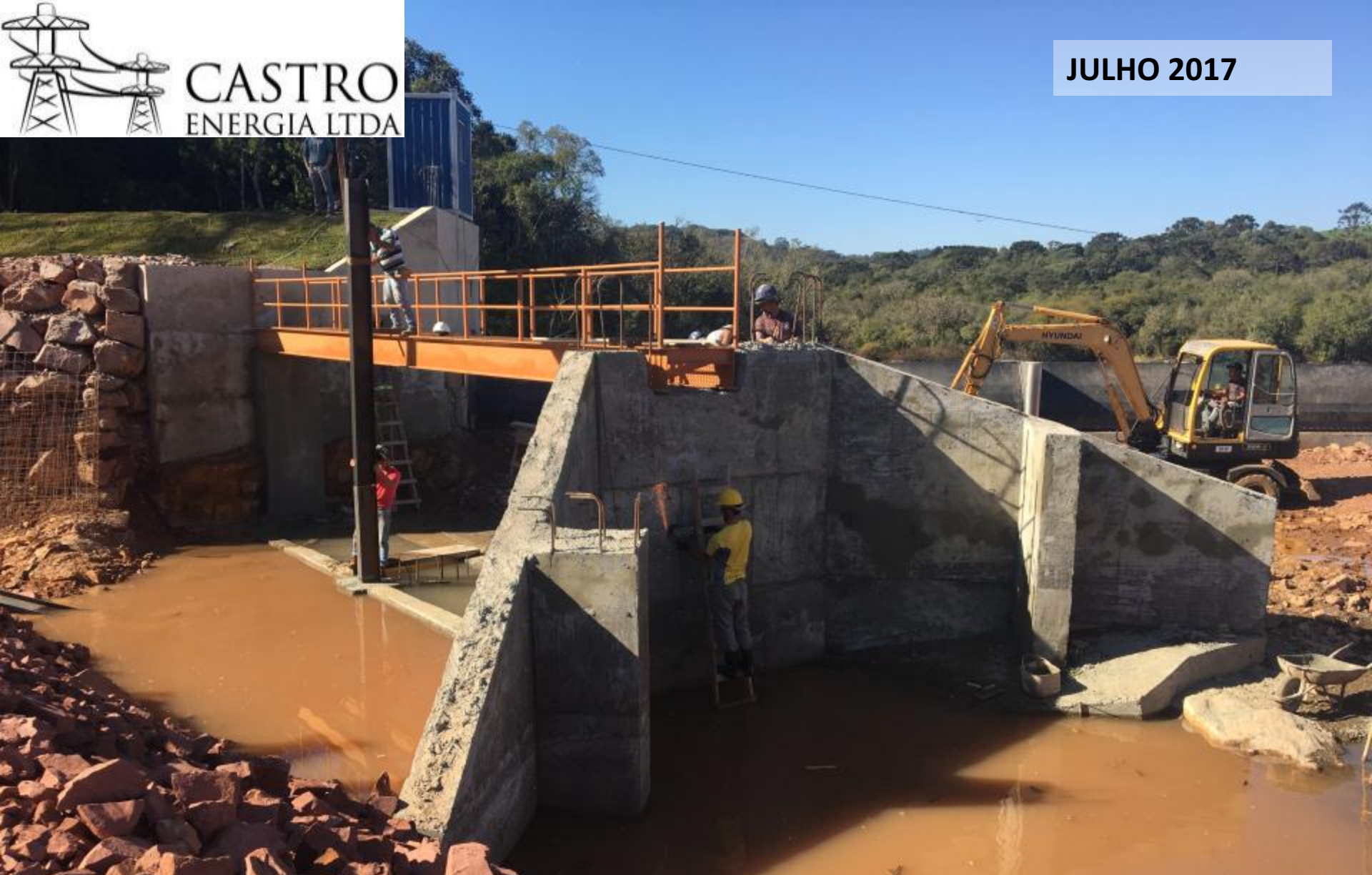
TOMADA DE ÁGUA DO CANAL INSTAÇÃO DA PASSARELA METÁLICA E PERFIS GUIA
