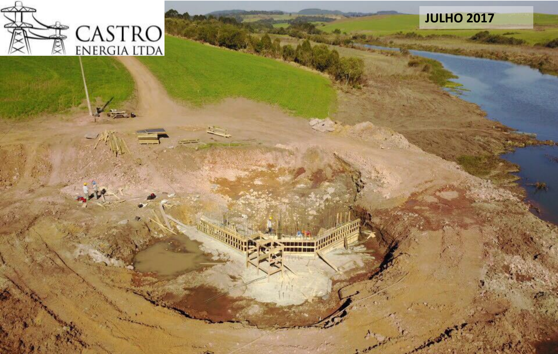
BARRAGEM VERTEDOIRO CONSTRUÇÃO DO MURO DA OMBREIRA DIREITA
