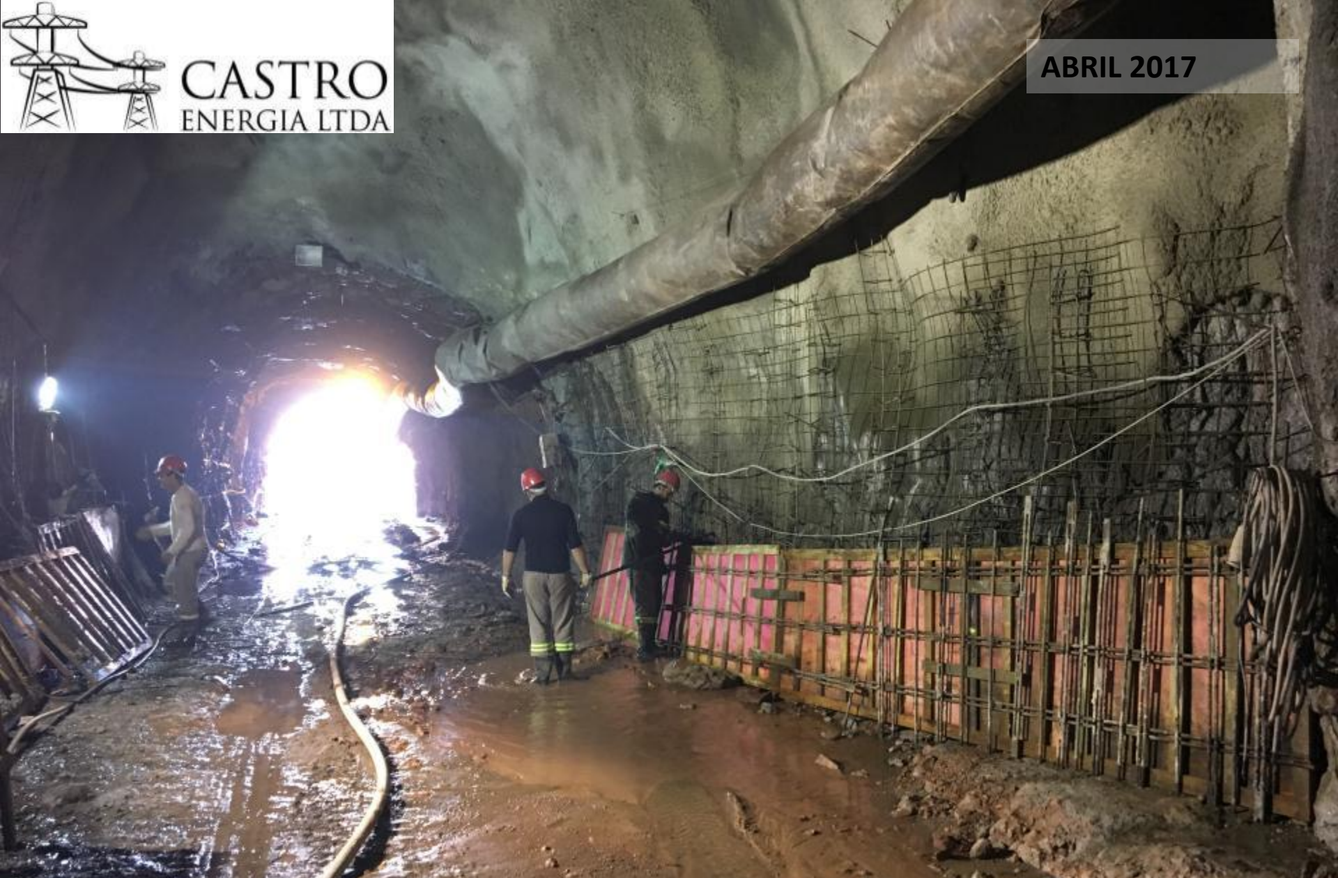
TÚNEL ADUTOR - JUSANTE EXECUÇÃO DE TRATAMENTOS – CONCRETO ARMADO EM ANDAMENTO
